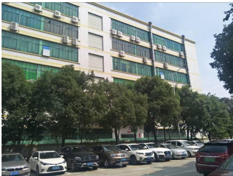
项目东面工业厂房
