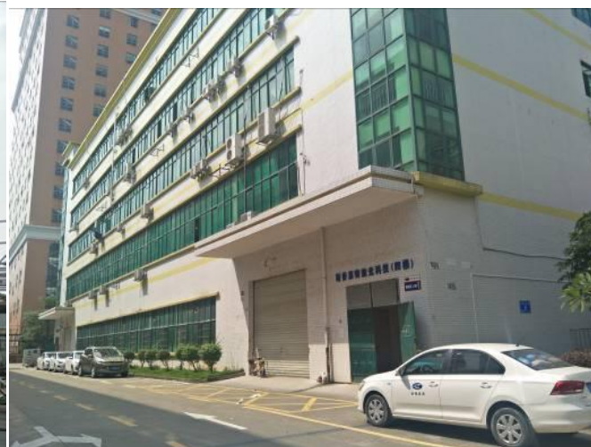
项目北面工业厂房
